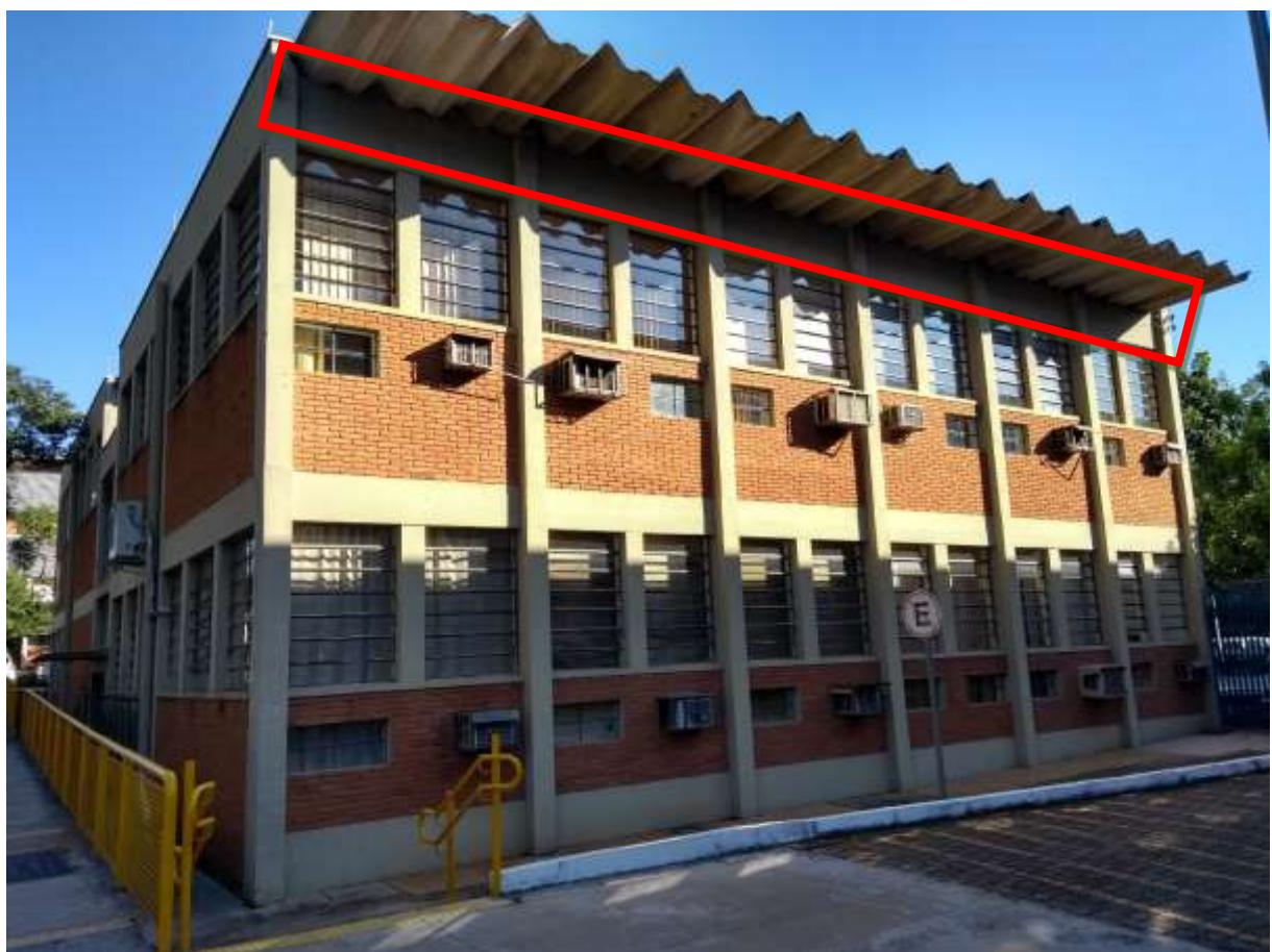
Após retirada das telhas, deverá ser elevada a alvenaria das platibandas identificadas, ou seja, das laterais voltadas para o prédio da Engenharia Mecatrônica e para a via de saída do campus (Física).
