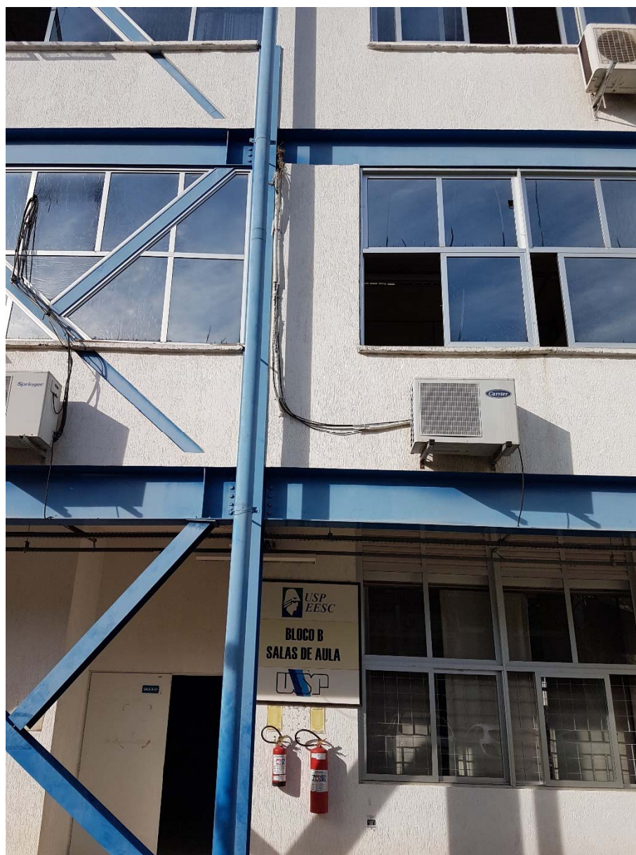
Estrutura metálica do prédio da Eng. de Produção a ser pintada
