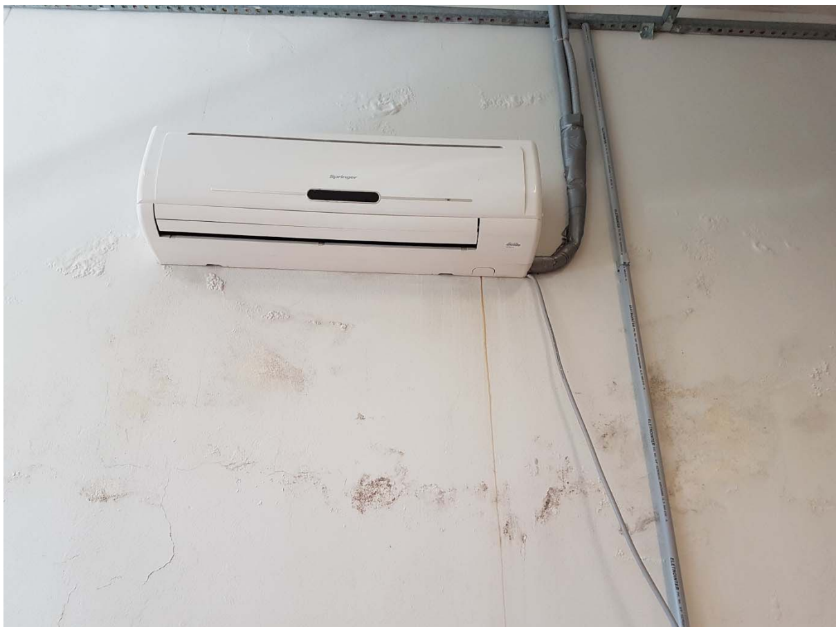
Região com acabamento degradado no prédio da Eng. de Produção
