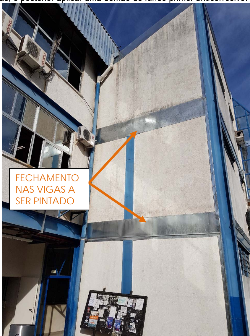
Exemplo de fechamento das vigas metálicas no prédio da Eng. de Produção
