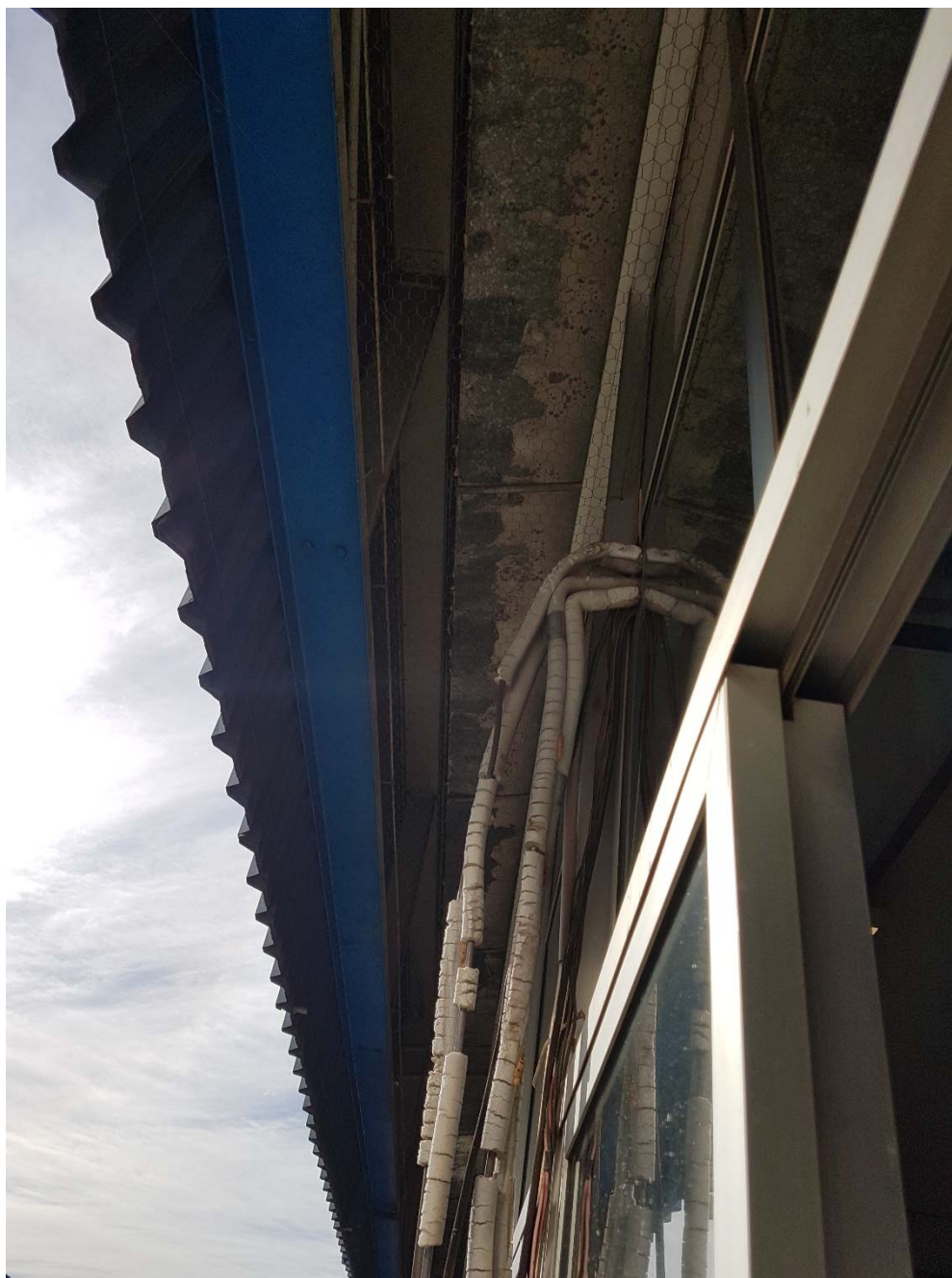
Fechamento lateral no prédio da Eng. de Produção com telhas metálicas a ser pintado. Incluso estrutura portante
